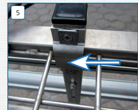
Montiertes Edelstahlhalteblech mit 2 Snapern unterhalb der Rohrtraverse
